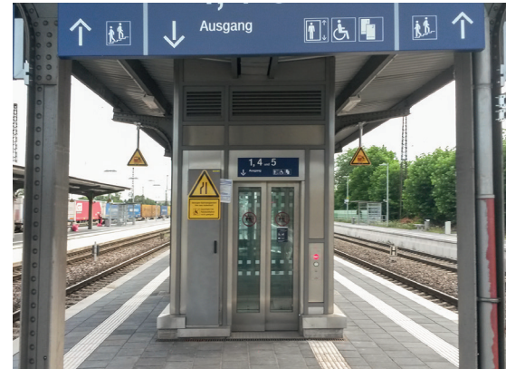
Abb. 5: Neuedingen-Friedrichsfeld, stufenfreier Zugang über Aufzug
