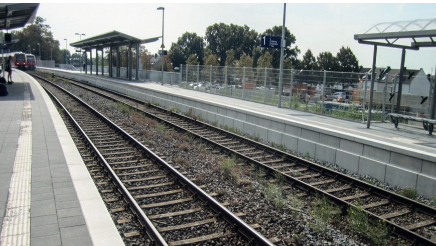
Abb. 6: Bahnsteig mit Regelhöhe 76 cm
