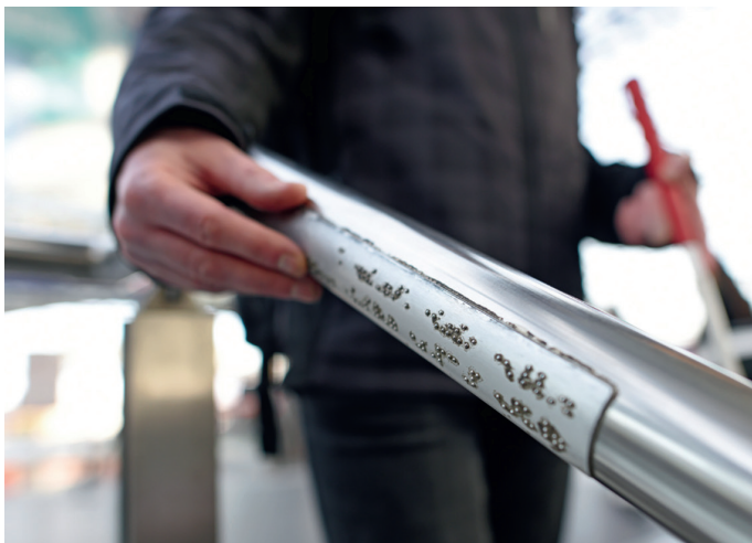
Abb. 11: Taktiler Handlaufschild mit Brailleschrift Quelle: O. Lang, DB AG
