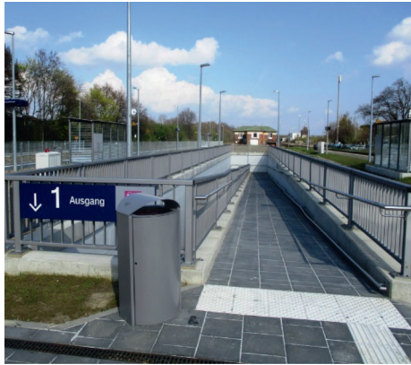
Abb. 4: Salzgitter-Ringelheim, lange Rampe zur Personenunterführung
