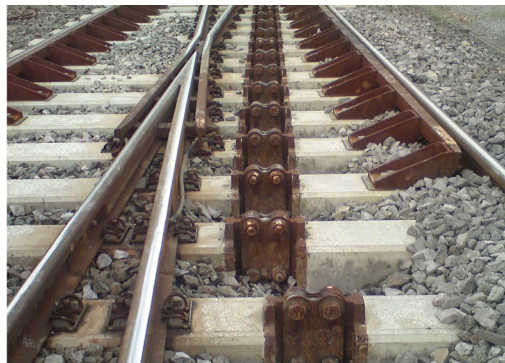
Eingebaute Klappweiche im Bhf. Oberhausen
