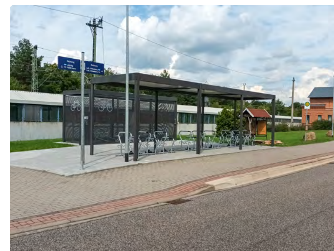
Sammelschließanlage Bahnhof Burgkernitz
