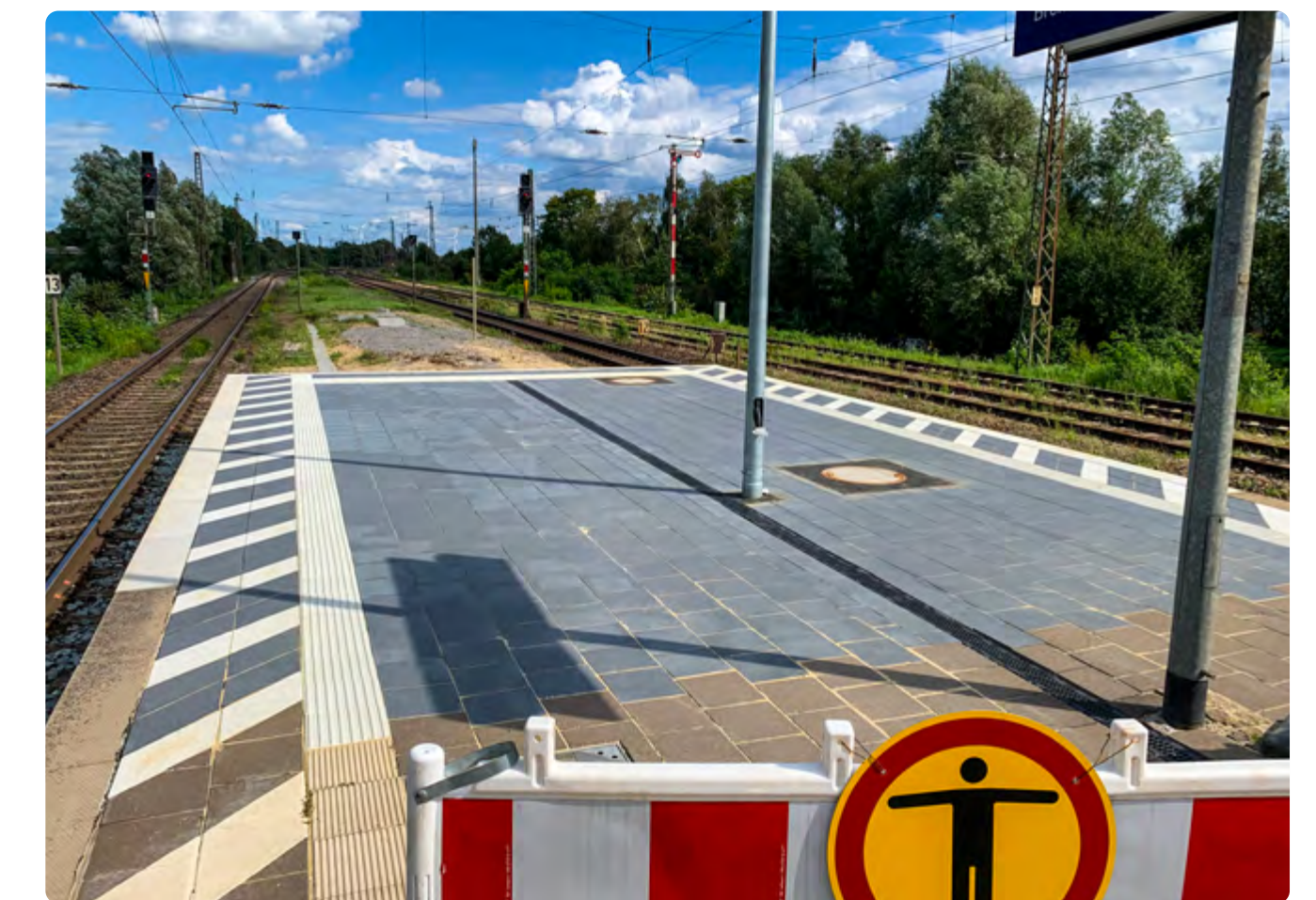
Bahnsteigverlängerung am Bahnhof Bremen-Oslebshausen
