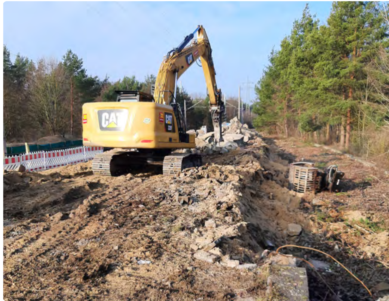
Abbruch der stillgelegten Gleise und Bahnsteige im Januar 2023
