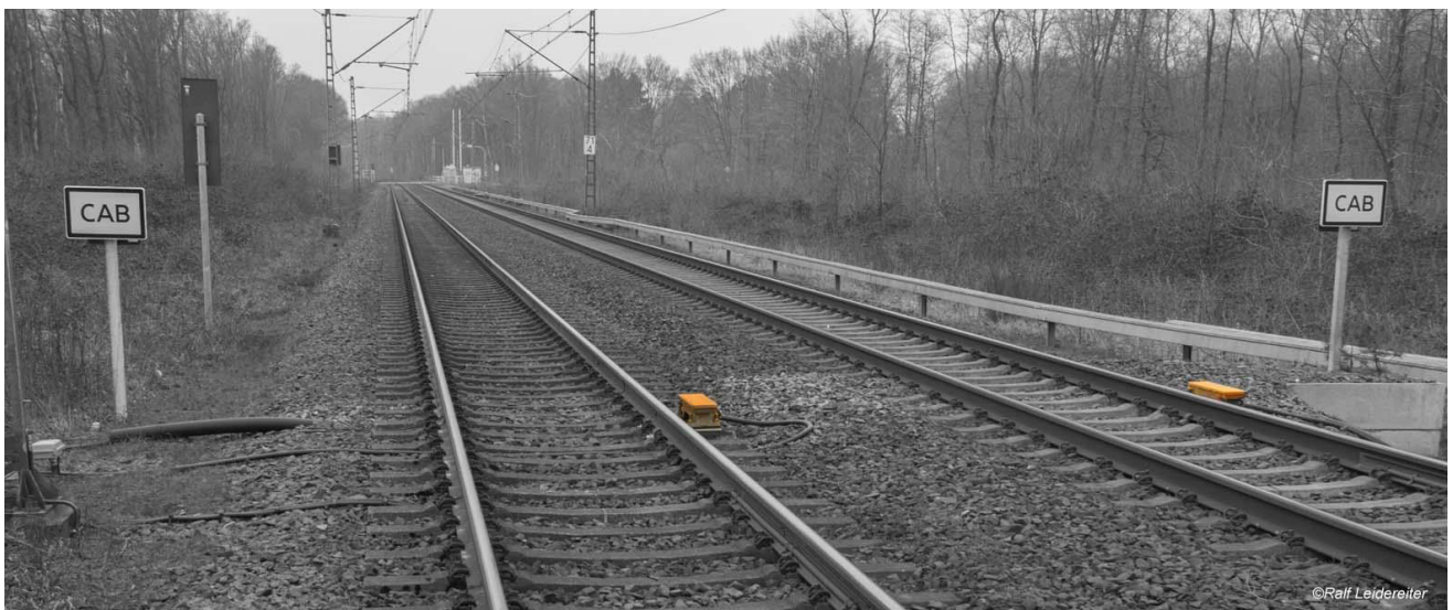
„CAB“-Signal 336 und 2000 Hz PZB-Magnete/CAB borden 336 en 2000 Hz PZB-magneten (km 71,353)
