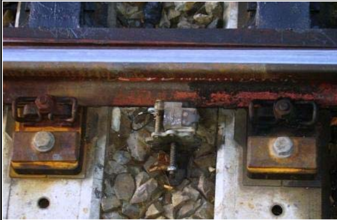
Bild 3-4 Handverschluss angebracht
