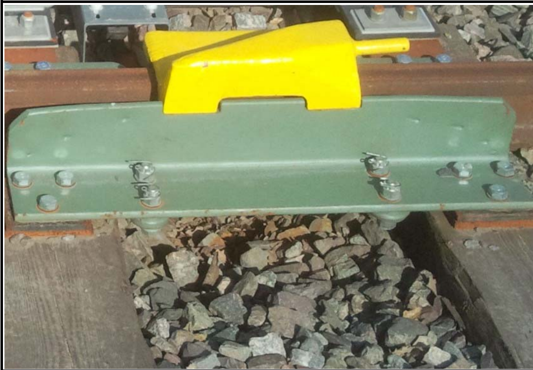
Bild 3-7 Gleissperre aufgelegt
