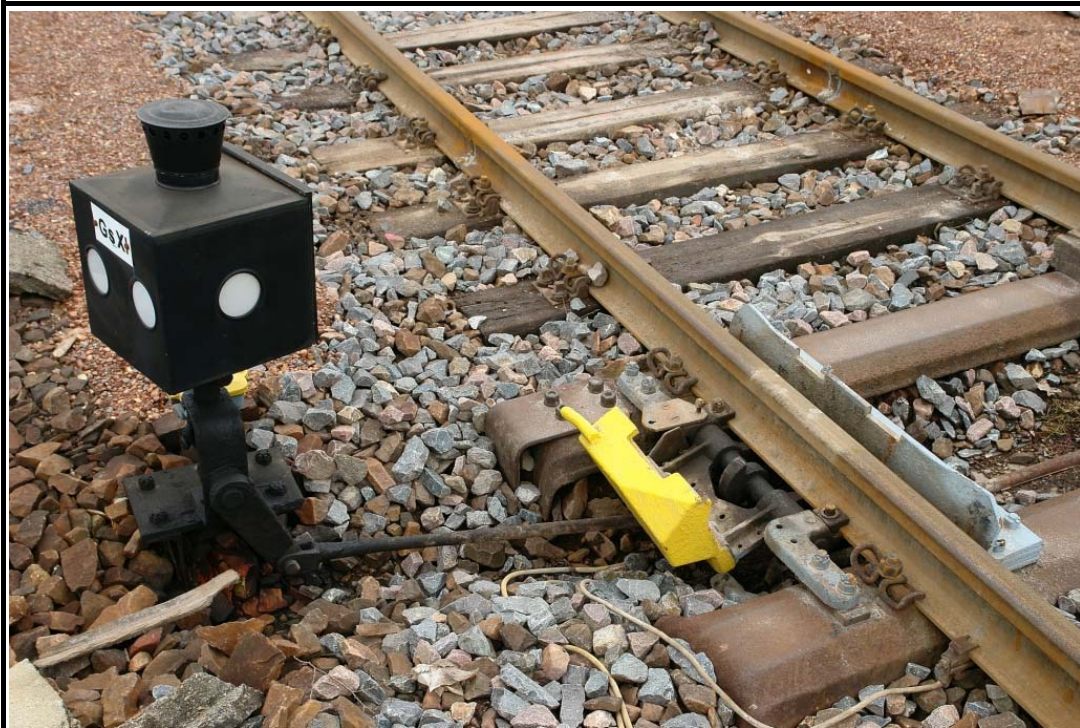
Bild 3-8 Gleissperre abgelegt
