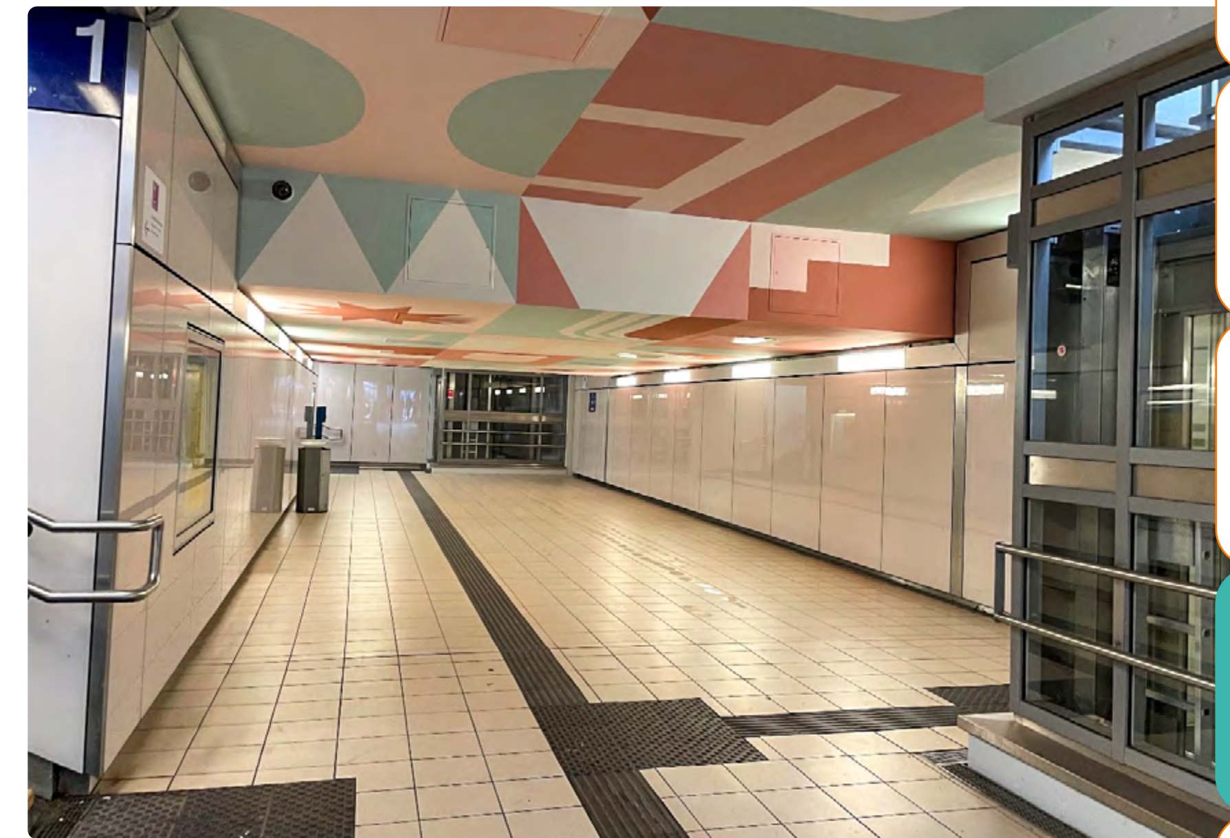
Die neu gestaltete Decke in der Personenunterführung.
