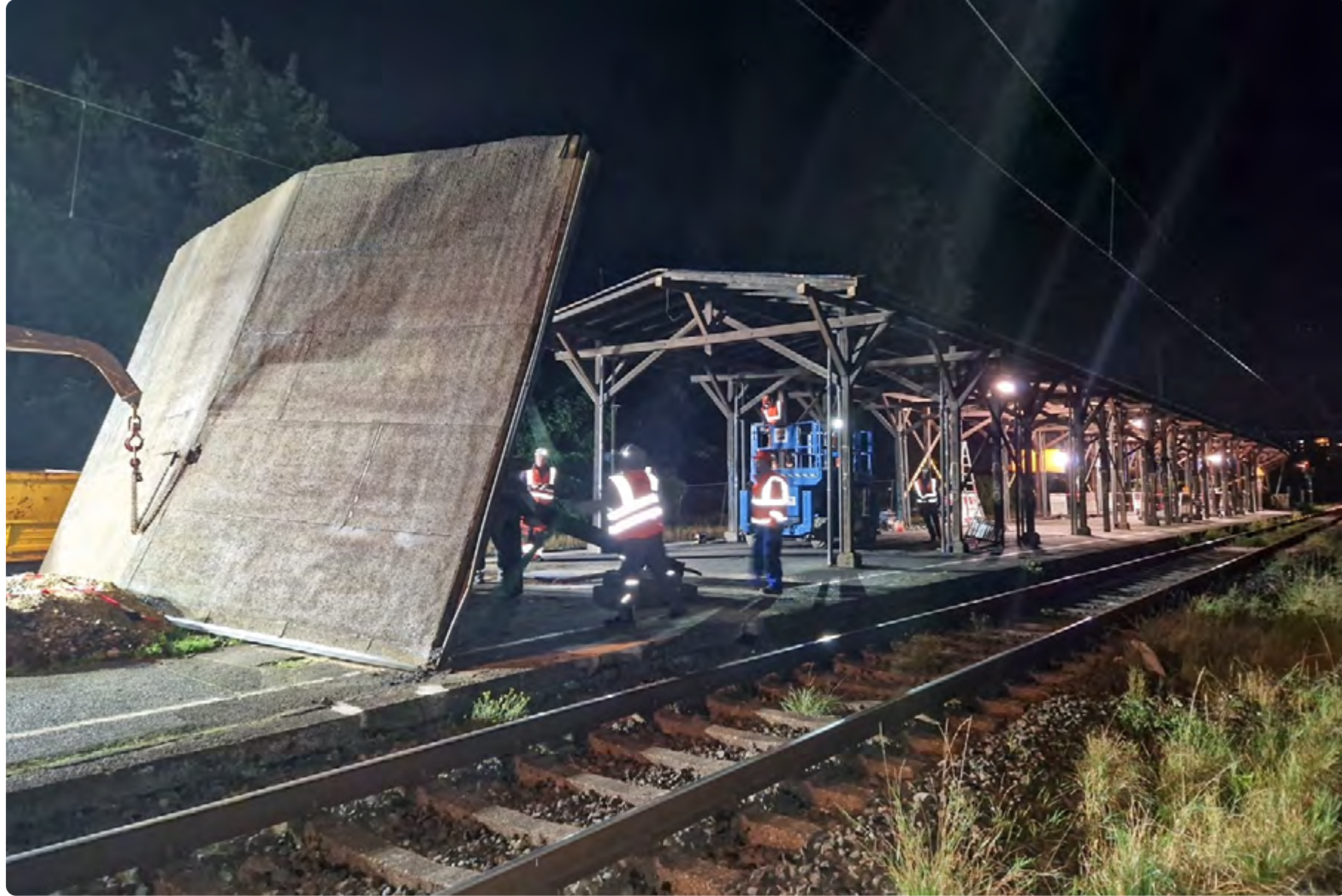
Das Bahnsteigdach wird im Rahmen der Modernisierung zurückgebaut.
