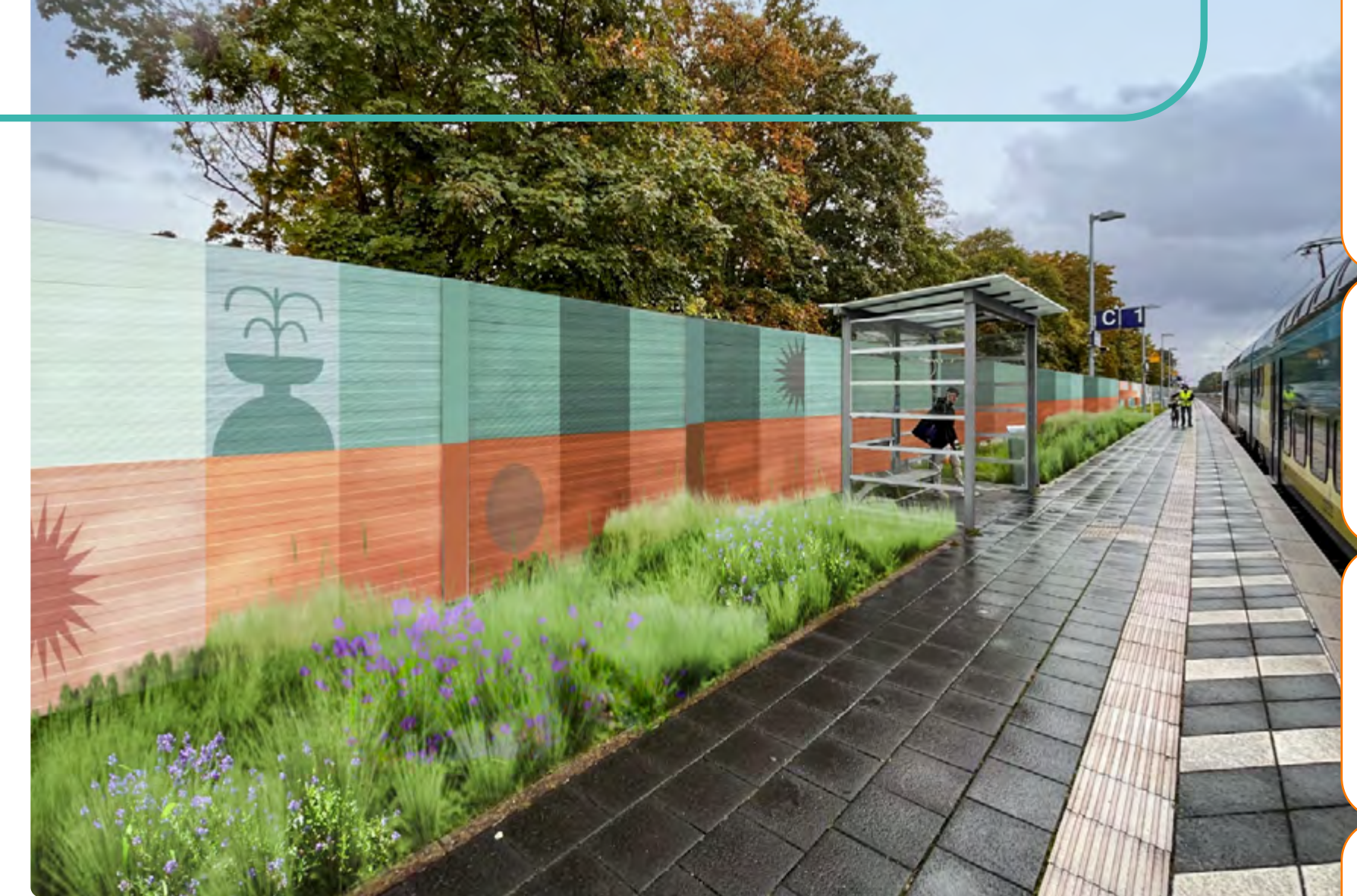
Die neue Gestaltung der Lärmschutzwand sorgt zukünftig für ein stimmiges Gesamtbild.
