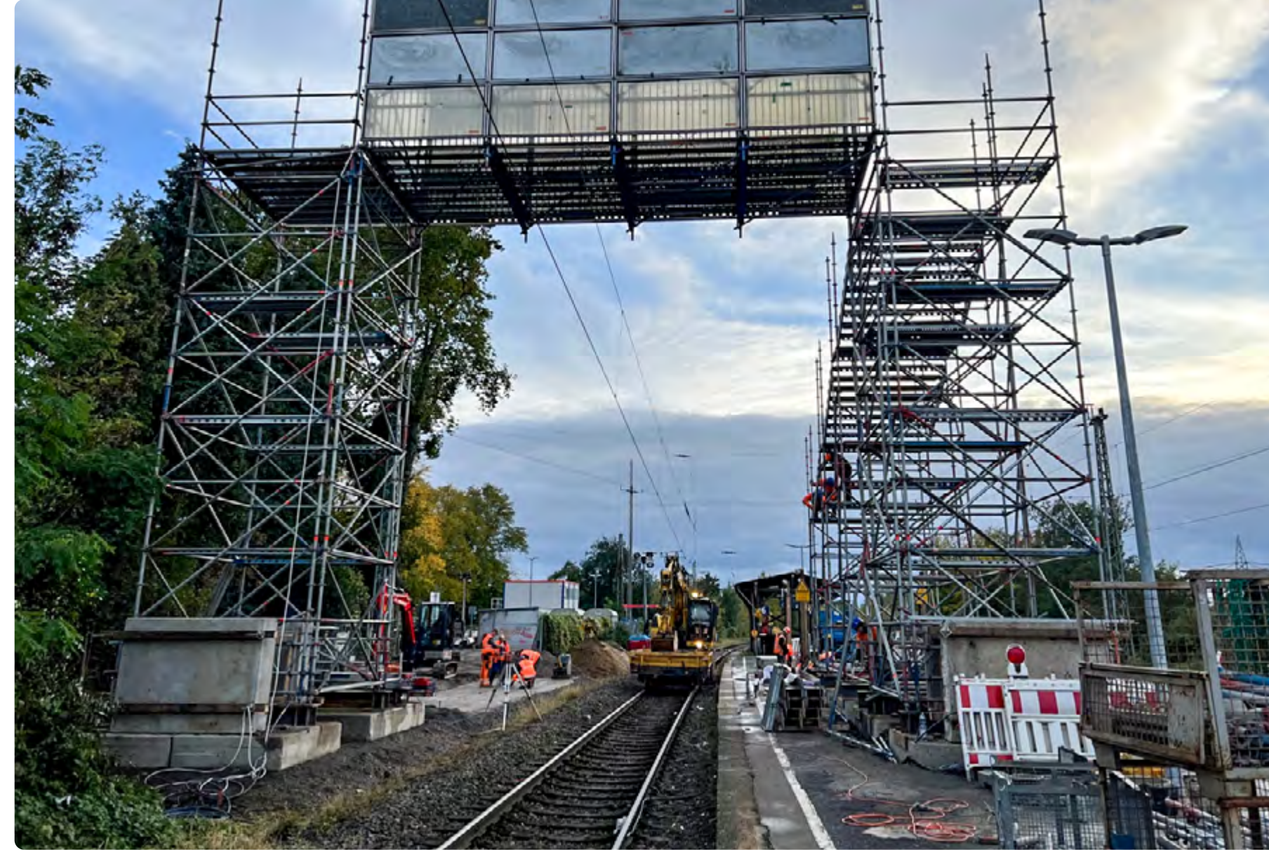
Die provisorische Personenüberführung im Bau.
