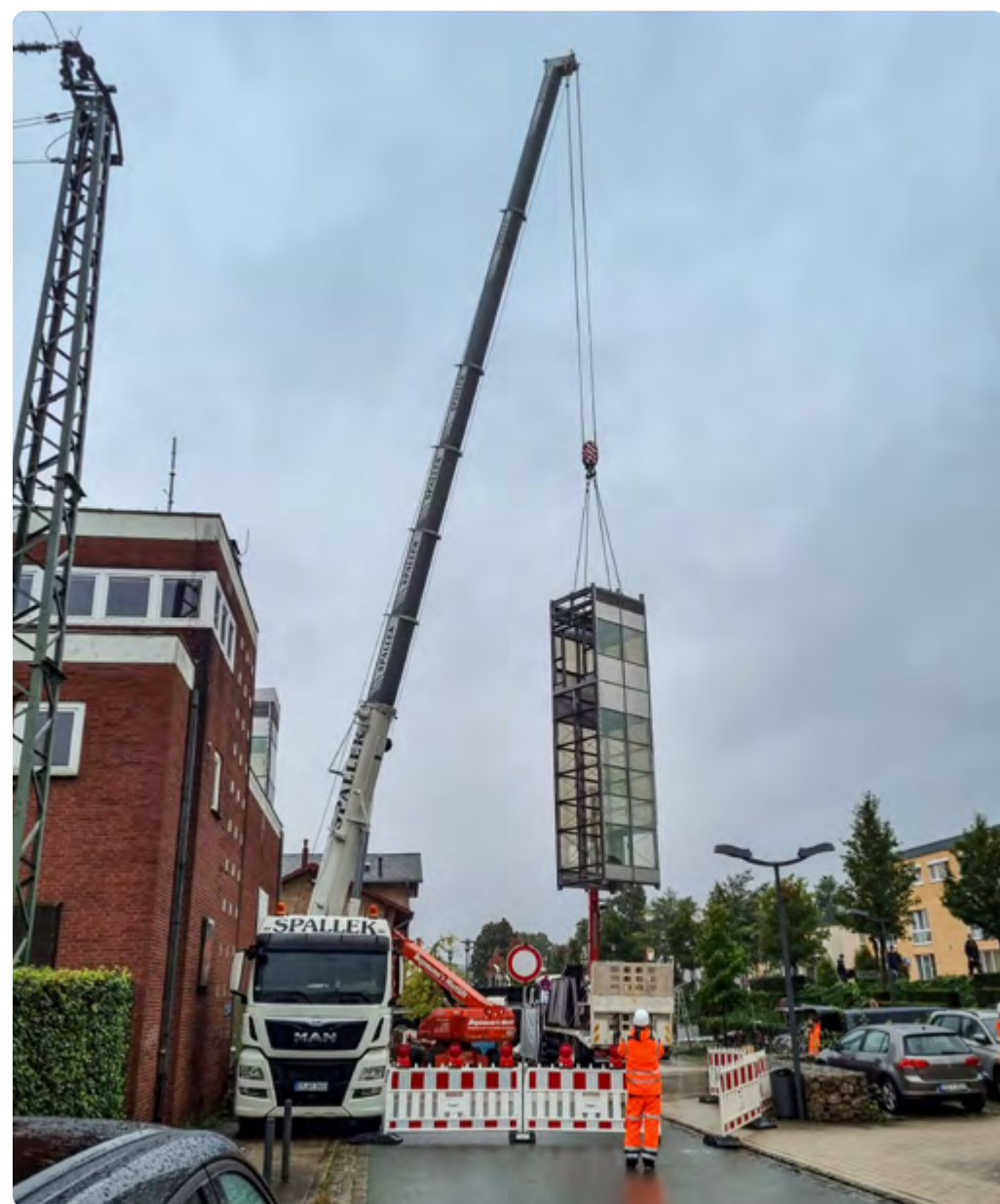
Eines der neuen Schachtgerüste wird mittels Kran zur neuen Überführung gehoben.
