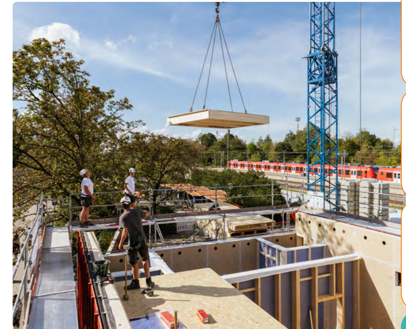
Blick auf die Baustelle Bahnhof Haar
