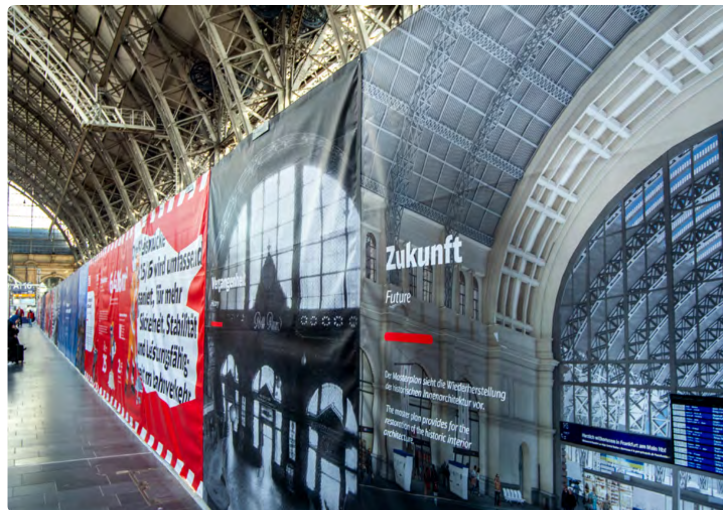
Die Baumaßnahme ist beidseitig mit zwei 2,50 m hohen Bauzäunen gegen Lärm- und Staubentwicklung abgeschirmt. Die Gestaltung erfolgte als Pilotprojekt.
