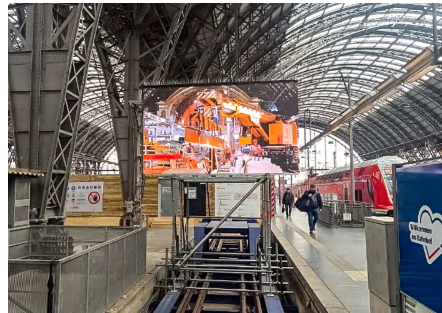
Am Kopfende von Gleis 16 befindet sich eine große Video-Wand, die Bilder von der dahinterliegenden Baumaßnahme zeigt.
