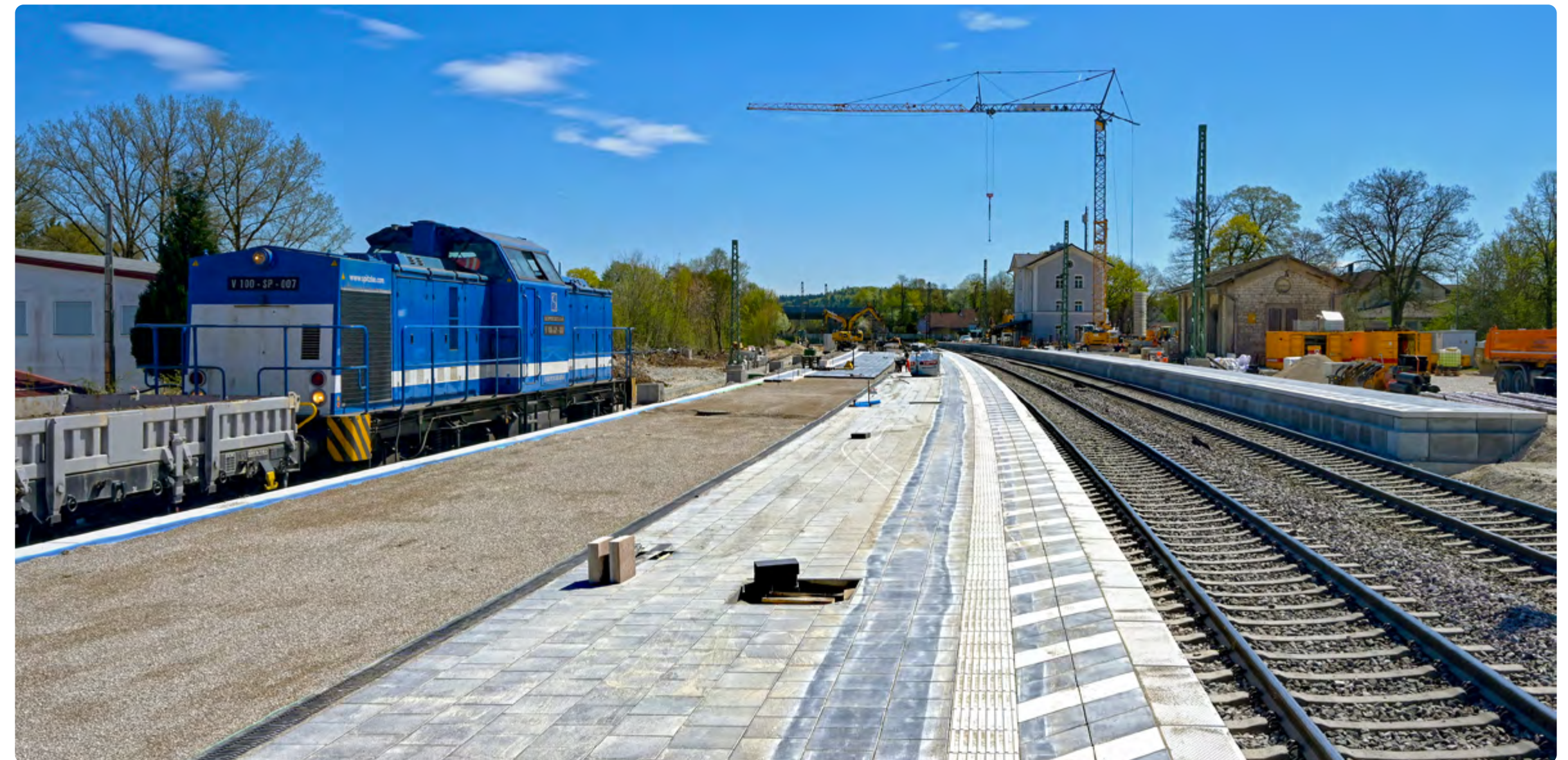
Bauarbeiten am Bahnhof Seubersdorf (April 2026)
