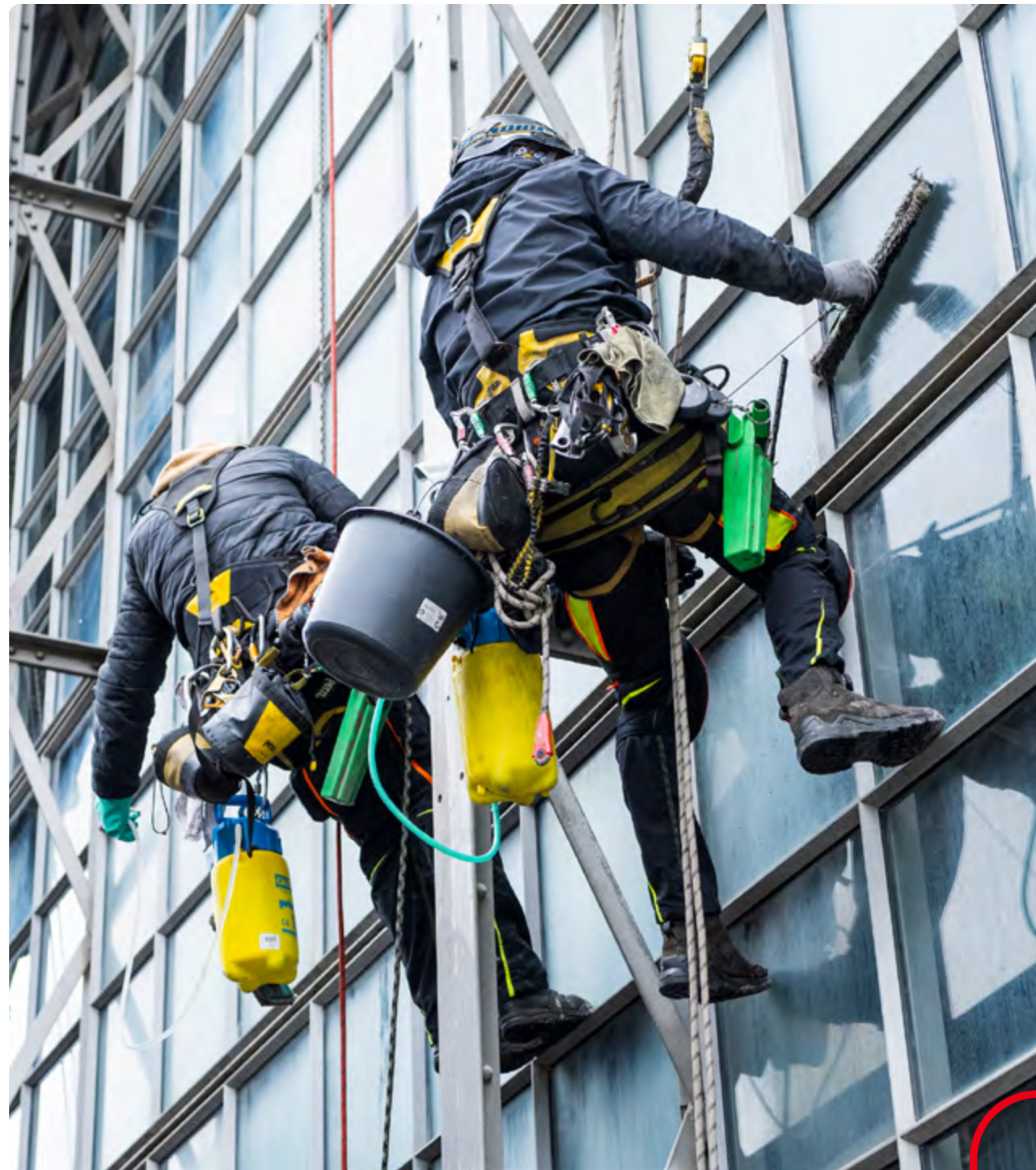
Glasreiniger auf dem Bahnhofsdach des Hauptbahnhofs in Frankfurt (Main)
