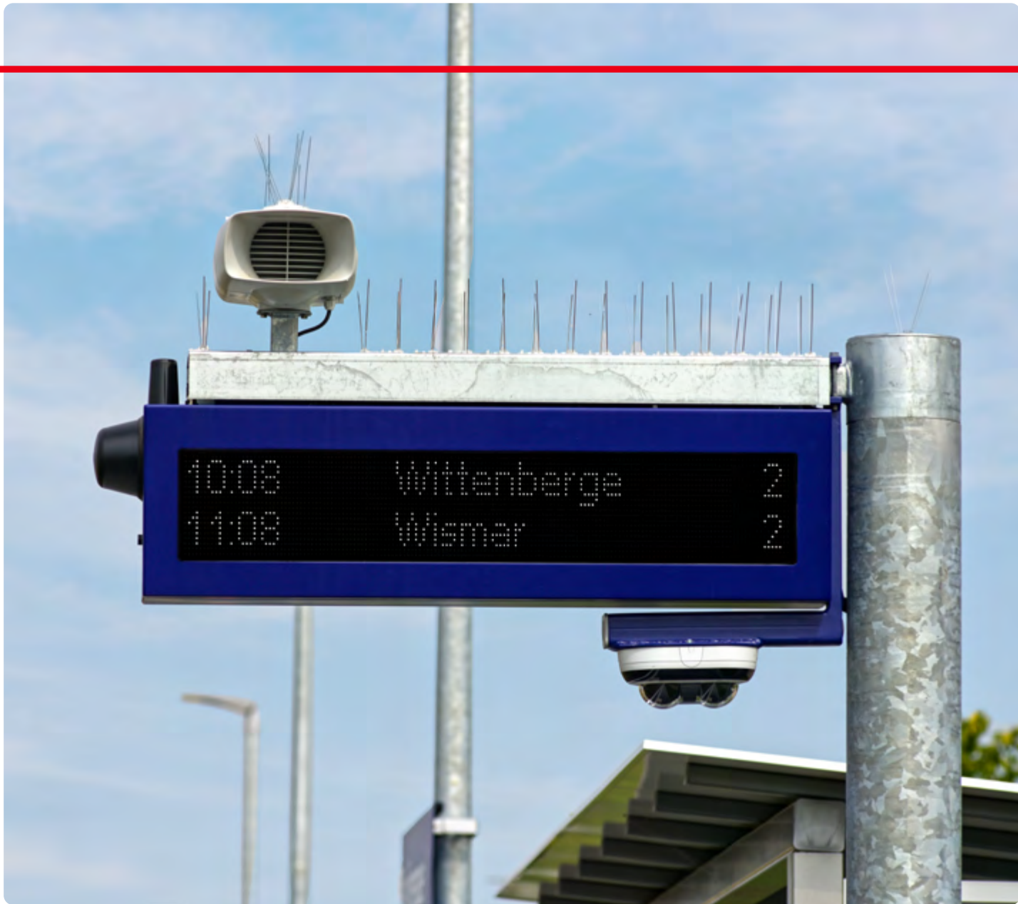
Dynamischer Schriftanzeiger am Bahnhof Paulinenaue inkl. Kamera
