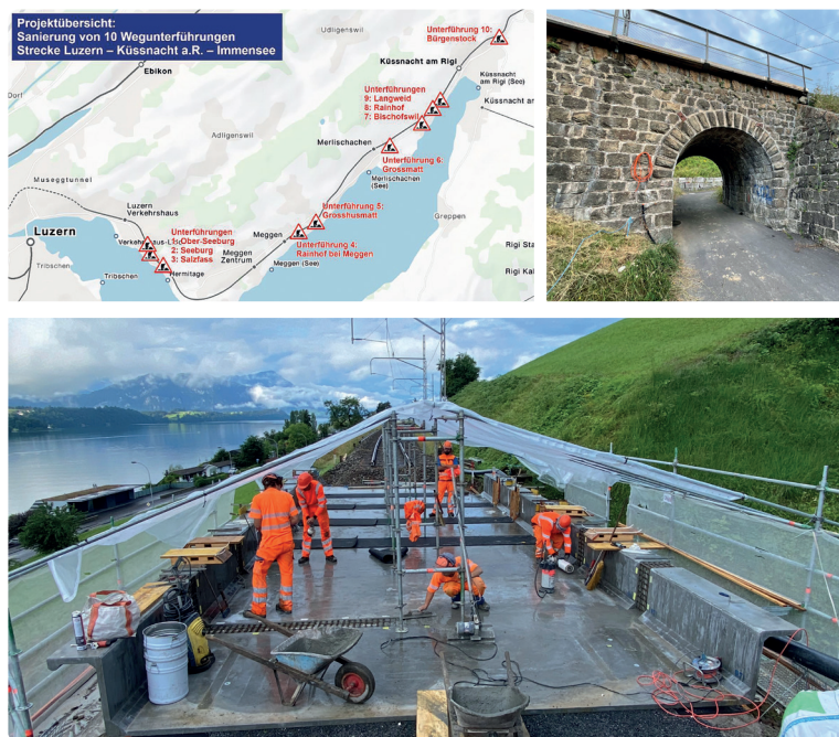
Abbildung 3: Bau von UHFB-Fertigteil-Fahrbahntrögen auf 10 kleinen Gewölbebrücken auf der Strecke von Luzern nach Immensee (Schweiz) – Quelle: Eugen Brühwiler (EPFL-Lausanne), Herbert Fridl (SBB CFF FFS)
