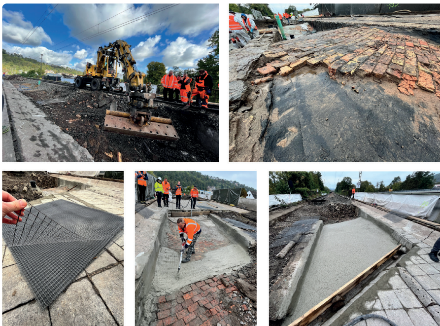
Abbildung 4: Textilbeton Applikation auf dem Gewölbebrücken des Kewag-Bogens in Koblenz – Quelle: DB InfraGO AG, Pelka
